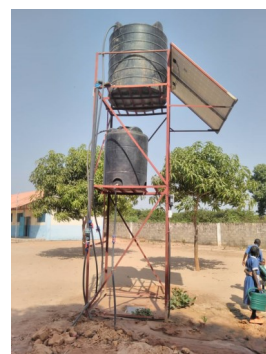
De wassertoren is klaar, met twee grote tanks
